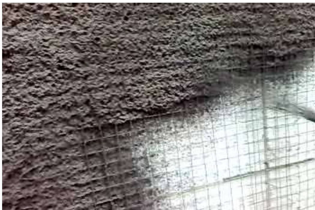
شکل ۱. یک نمونه شانکریت با بتن الیافی با الیاف ۶ میلیمتری پلی پروپیلن [۱۴]
