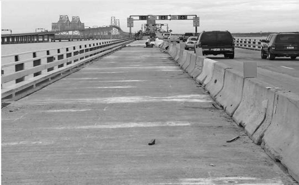
شکل ۲. یک نمونه دال پل که در کانزاس آمریکا با بتن یافی ساخته شده است.
